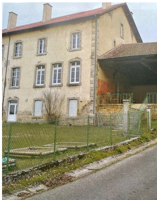
Les locaux de l'ancienne cantine s'ouvrent sur le rez de jardin du bâtiment de la mairie
