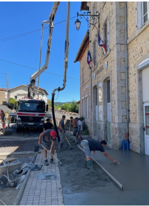
Parvis de la mairie Fin des travaux mars 2026
